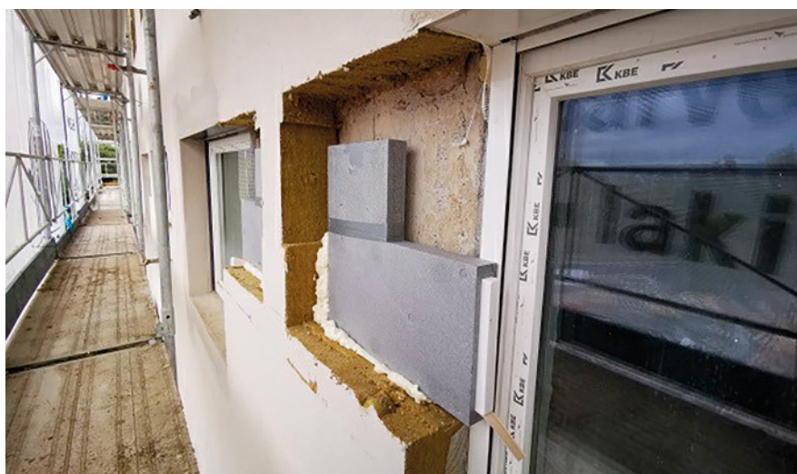
SmartFan SilentAir – Instalace do ostění
